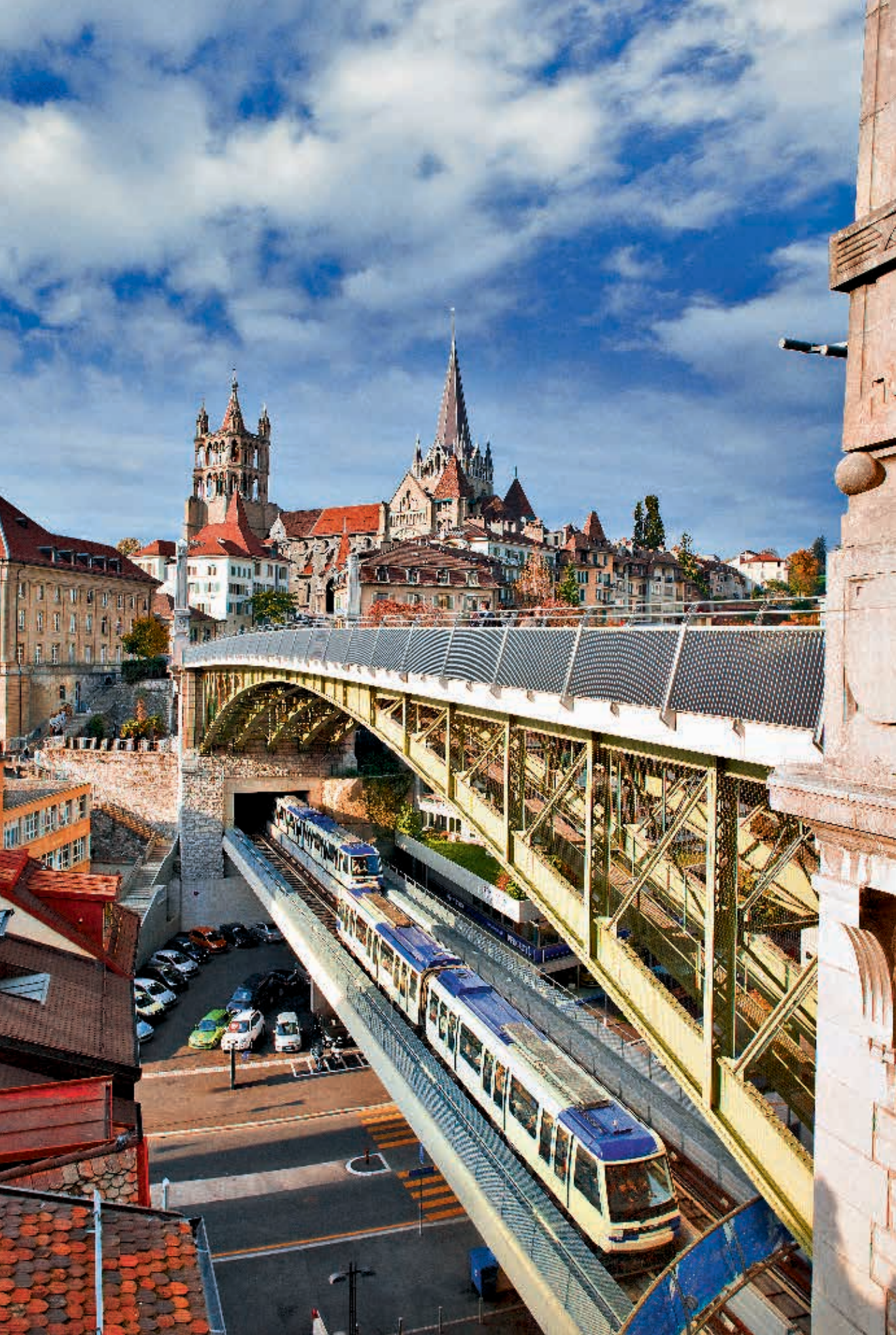
Le m2 qui passe entre les arches du Pont Bessières.
